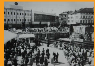
Baustelle am Synagogenplatz; jüdische Gemeinde
