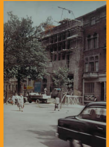
Rohbau; jüdische Gemeinde Aachen
